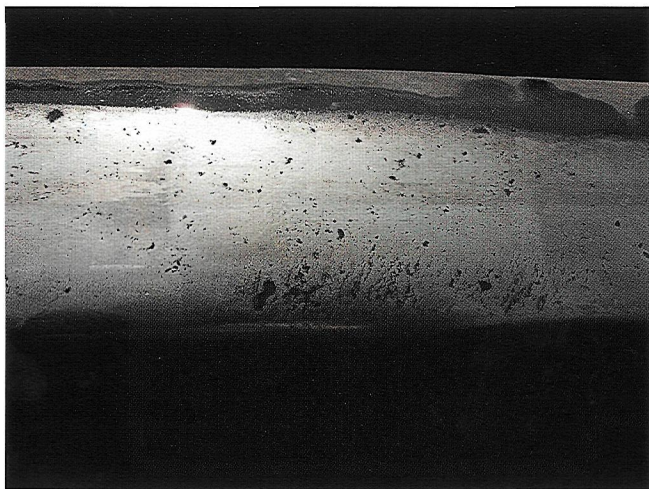
Рис. 17. Микротрещина только в сварном стыке
