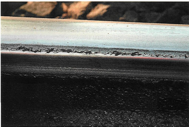
Рис. 9. Образование единой продольной трещины
