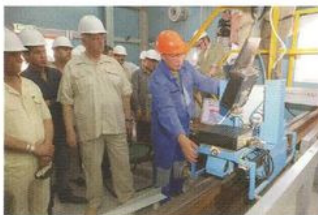
Рис. 7. Контроль сварного стыка рельсовой плети на РСП в г. Рас-Лануф
