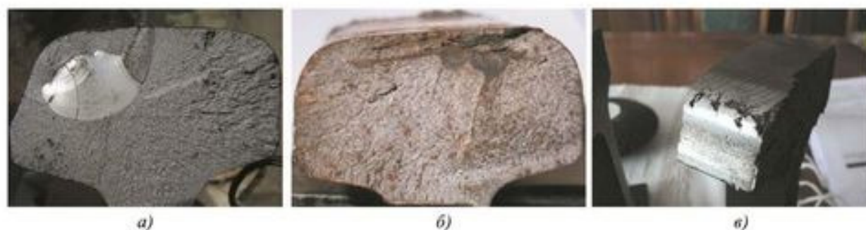
Рис. 1. Характерные дефекты в рельсах:
